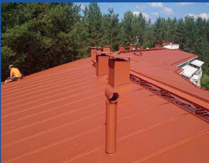
Indurust-peltikattopinnoitus Joensuussa, 1.200 m 2 . Samalla uusittiin kattoturvatuotteet.
