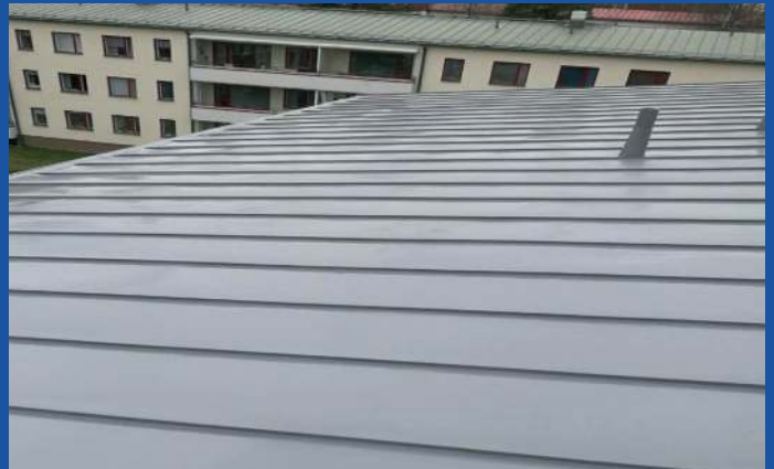
Polyurea 2k kuumana levitettävä pinnoite Vantaalla, 900 m 2 . Kyseessä oli vuotava peltikatto.
