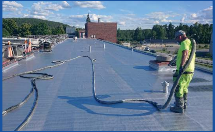
Alumiininharmaa polyurea heijastava pinnoite ei tarvitse pintamaalausta. Pinta lämpenee marginaalisen vähän.
