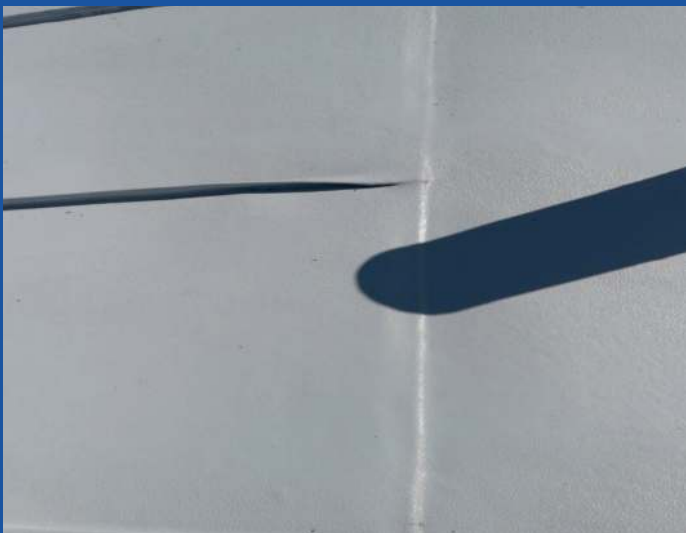
Polyurea tiivistää vuotavat saumat 100%:sti.
