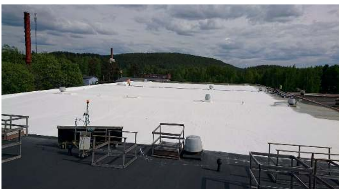
ThermaCote-lämmöneristyspinnoite Vaajakoskella, 6.000 m 2
