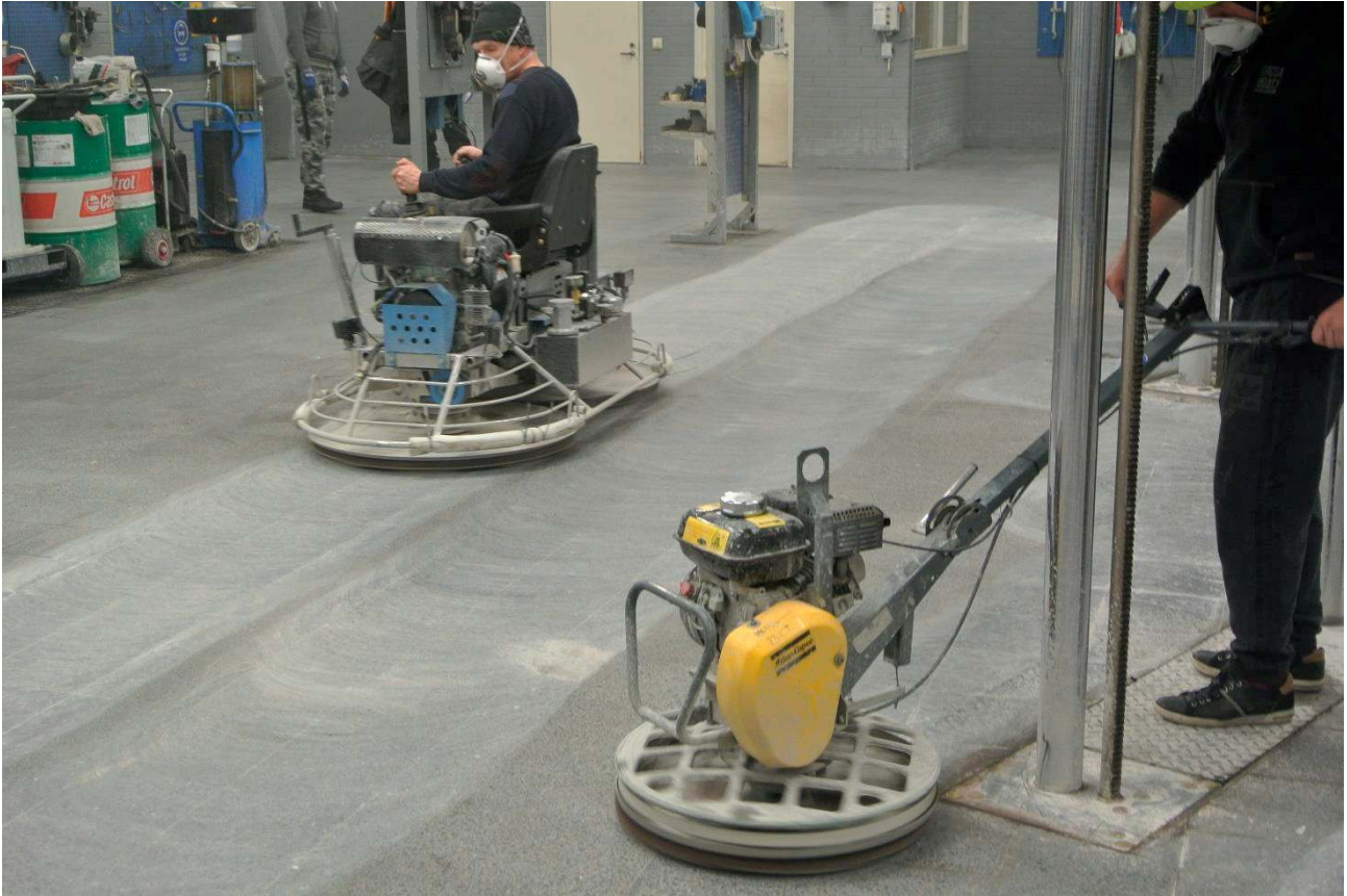
Kuva: Lattian hiontaa ja -suojausta Autotalo Laakkosella Kuopiossa.
