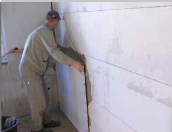
Climate Board-materiaalin asettaminen
