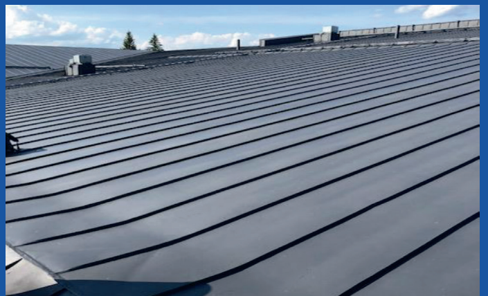
Indurust-peltikattopinnoitus Kuopiossa , 4.000 m 2
