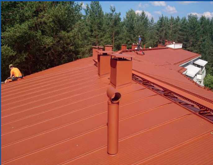
Indurust-peltikattopinnoitus Joensuussa, 1.200 m 2 . Samalla uusittiin kattoturvatuotteet.
