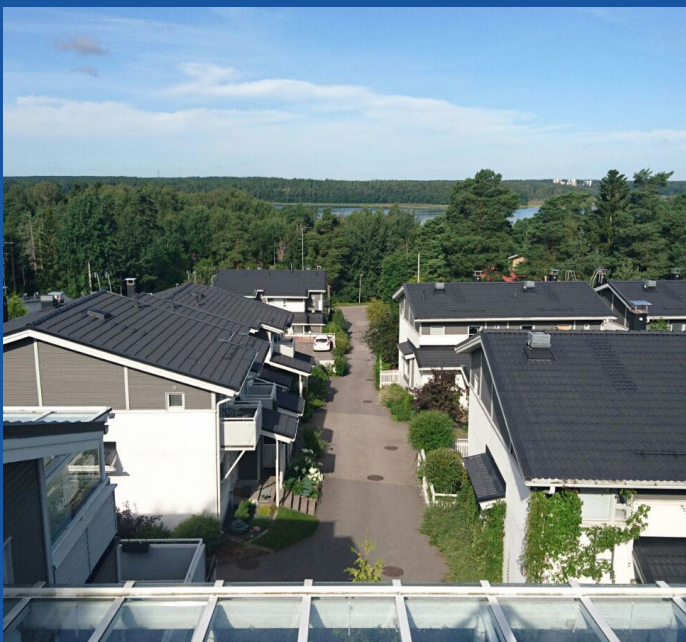
Tiilikattojen pinnoitus Espoossa.
