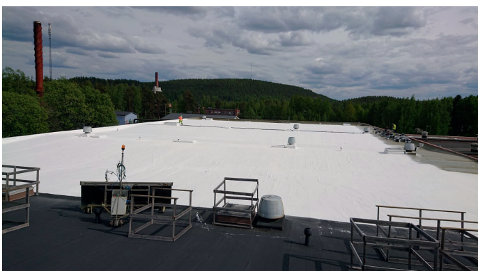
ThermaCote-lämmöneristyspinnoite Jyväskylässä, 6.000 m 2
